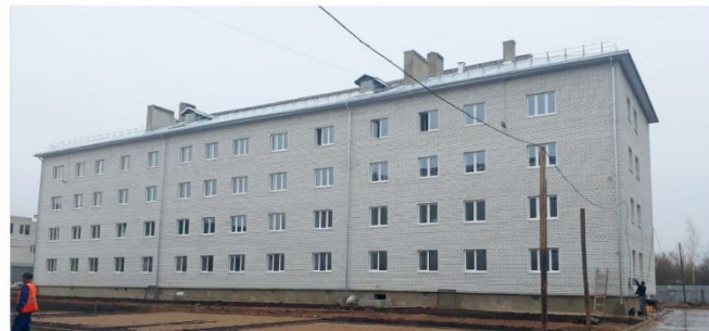
ДОМ № 2 НА 40 КВАРТИР В ПОС. ОКТЯБРЬСКИЙ (СДАН 30.10.2020)
