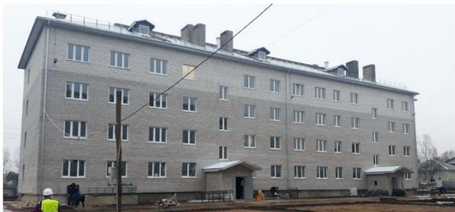
ДОМ № 1 НА 40 КВАРТИР В ПОС. ОКТЯБРЬСКИЙ (СДАН 30.10.2020)
